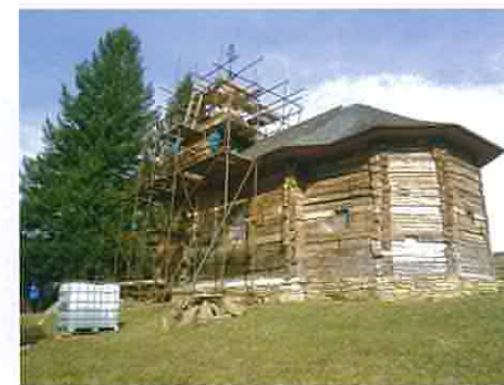
Rekonštrukcia chrámu v Šmigovci
